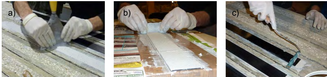
Figura 4.27. a) aplicação de uma camada de resina sobre a superfície de betão; b) aplicação de uma camada de resina sobre a superfície do laminado; c) rolo metálico a realizar pressão sobre o laminado.
