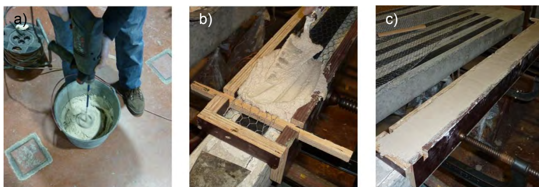
Figura 4.38. a) preparação da argamassa de VP com recurso a misturadora eléctrica; b) preenchimento das cofragens com ajuda de uma colher; c) vista geral do sistema de protecção.
