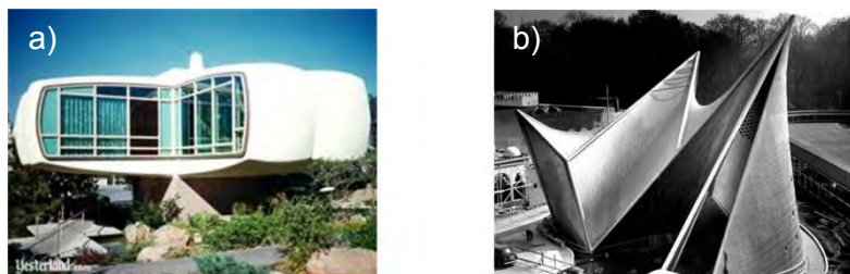
Figura 2.2. a) “ Monsanto House of the Future ” – revestimentos em compósitos de fibras de vidro [2.9]; b) “ American Pavilion in Brussels ” – fachadas totalmente em compósito de fibra de vidro [2.10].
