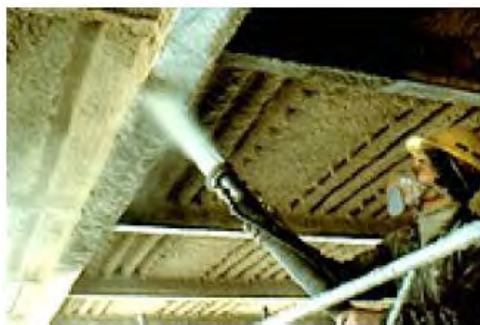
Figura 3.20. Projecção de fibras minerais num pavimento metálico [3.31].
