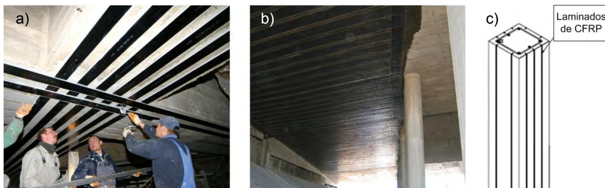
Figura 2.11. a) reforço à flexão de vigas de um complexo industrial com recurso a laminados de CFRP [2.43]; b) reforço à flexão de uma laje do tabuleiro de um viaduto com recurso a mantas de CFRP [2.43]; c) esquema do reforço de um pilar à flexão com laminados de CFRP [2.47].
