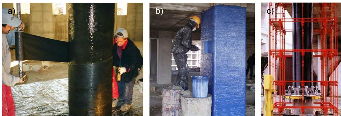
Figura 2.13. a) encamisamento com mantas de CFRP para reforço axial de um pilar circular [2.43]; b) encamisamento com mantas de CFRP para reforço axial de um pilar rectangular [2.43]; c) mecanismo para encamisamento automático de um pilar circular com fios de CFRP [2.43].
