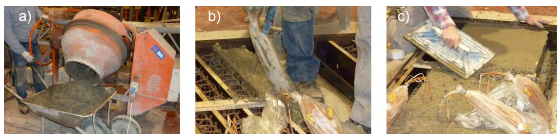
Figura 4.25. a) betoneira basculante eléctrica; b) colocação e vibração simultânea do betão; c) regularização da superfície do betão.
